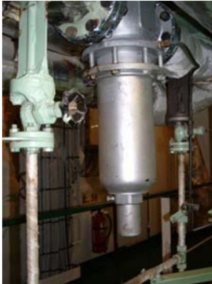
Slika 9. Ventil za kontrolu tlaka (Vlačić, 2006)
