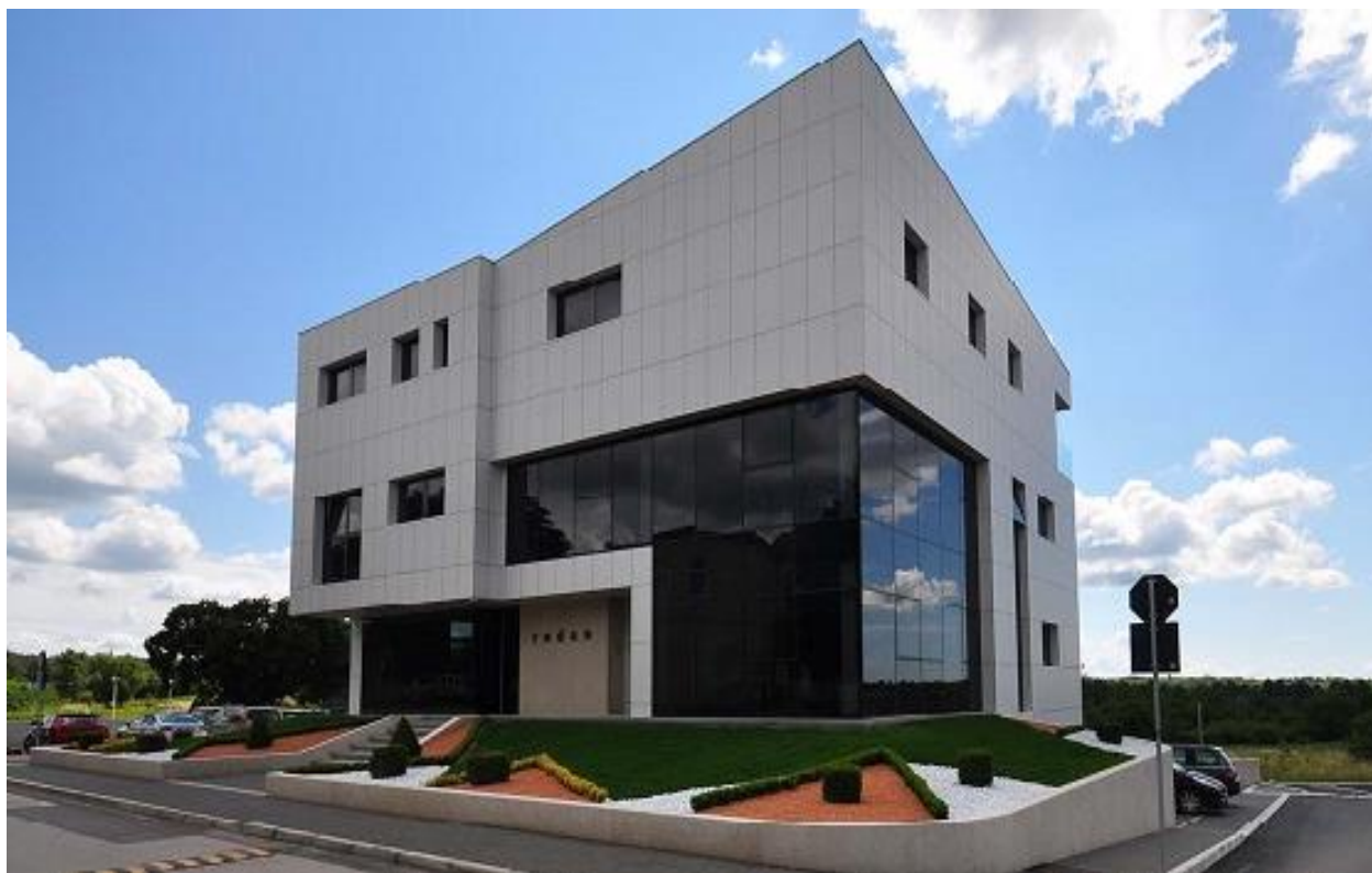
Slika 12: Pasivna poslovna zgrada u Žminju
