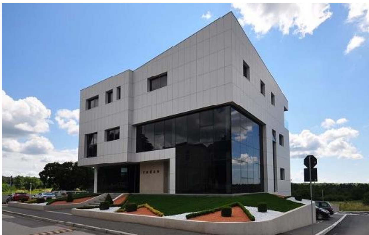
Slika 12: Pasivna poslovna zgrada u Žminju
