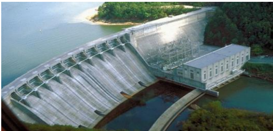
Slika 4. Hidroelektrana u Hrvatskoj ( Izvor : http://www.lolhr.com/blogovi/energetika/39-hidroelektrane-u-hrvatskoj.html , 2016.)
