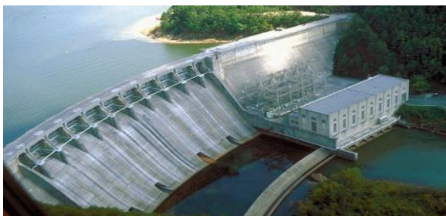
Slika 4. Hidroelektrana u Hrvatskoj ( Izvor : http://www.lolhr.com/blogovi/energetika/39-hidroelektrane-u-hrvatskoj.html , 2016.)
