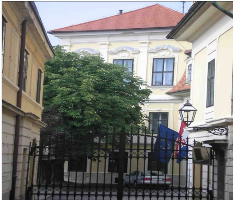
Slika 3. Zgrada u Visokoj ulici u Zagrebu nekadašnjeg Ministarstva inozemnih poslova RH
