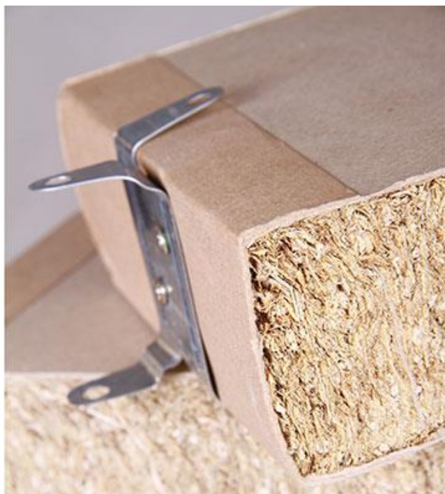
Slika 37: Presjek panela od prešane slame
