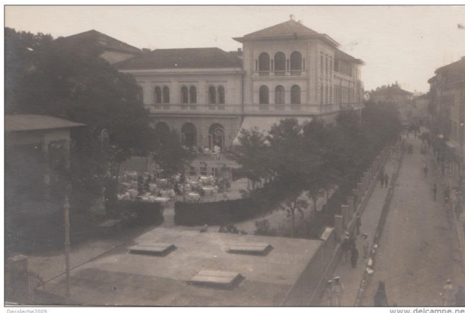
Slika 23., Zgrada novog Marine Kasina, pogled na vrtnu terasu.
