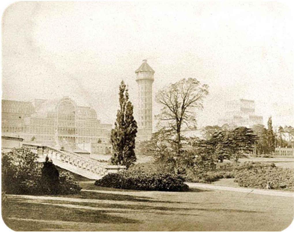
Slika 17. Jedan od tornjeva za napajanje fontana vodom
