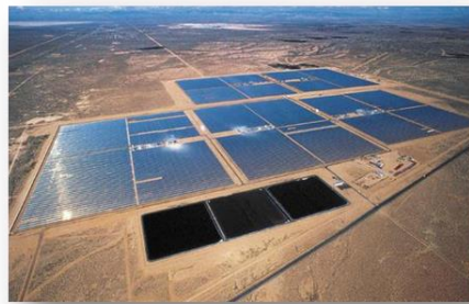
Slika 3: Parabolična protočna TE 30 MWe, Kramer Junction, California
