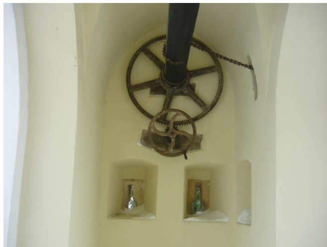
Slika 3. Puškarnice i mehanizam za otvaranje mosta
