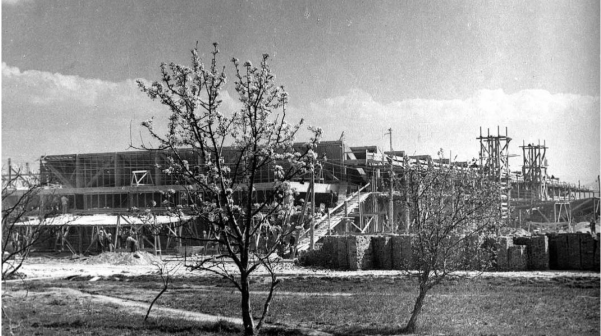
Slika 1. Izgradnja tvornice „Dalmatinka“ 11
