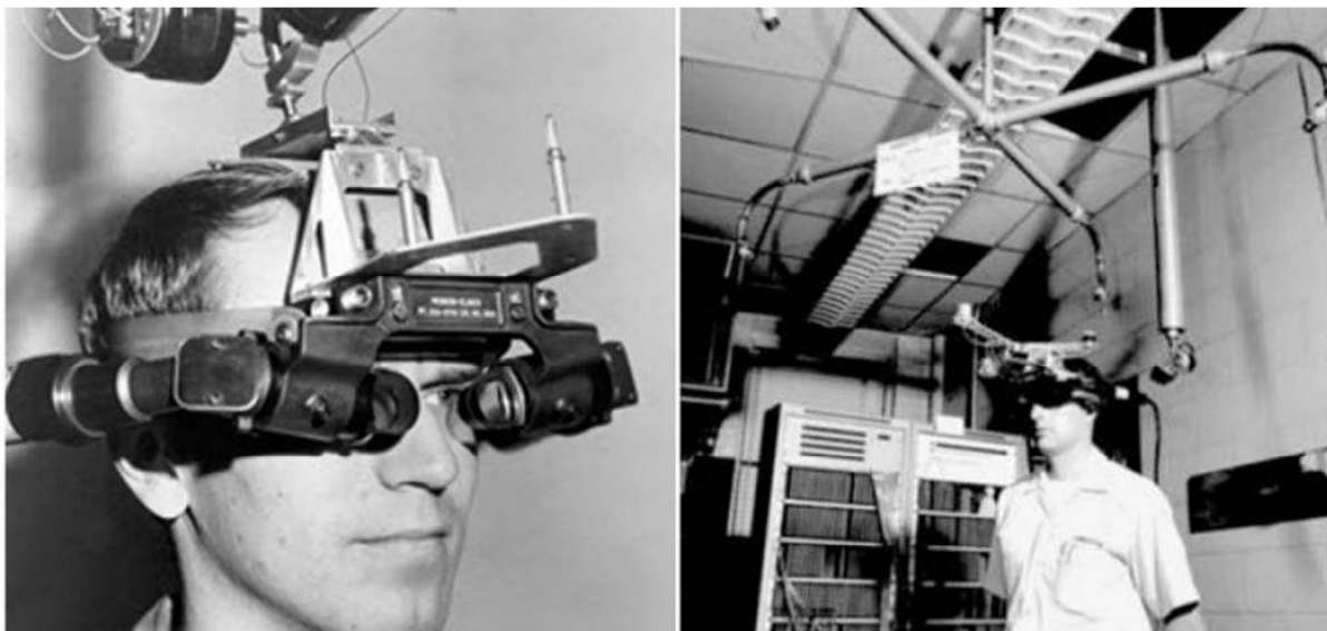
Slika 5 Prvi HMD uređaj, dijelo Ivana Sutherlanda
