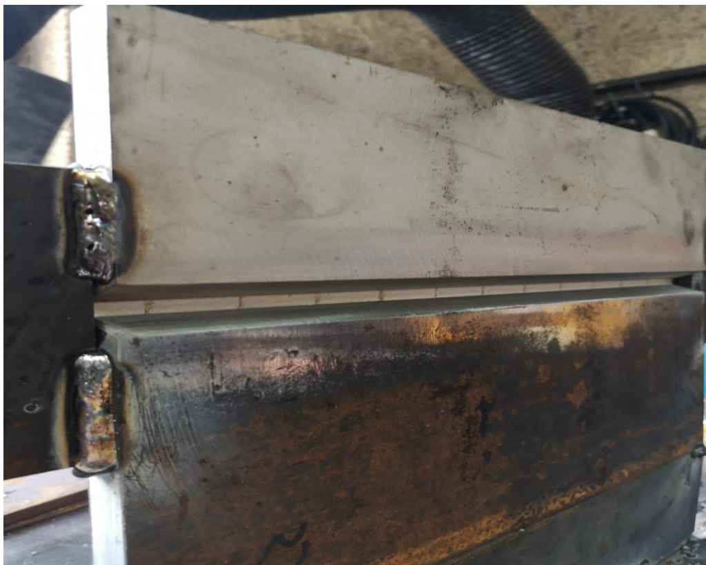
Slika 9 Pravilno postavljen spoj, pod pravim kutom
