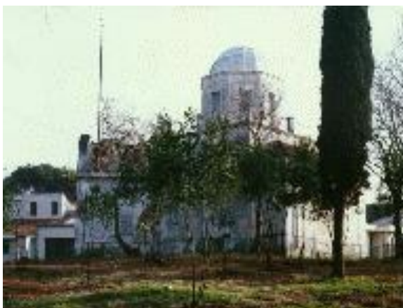
Slika 2. Izgled Zvjezdarnice (prije sanacije)
