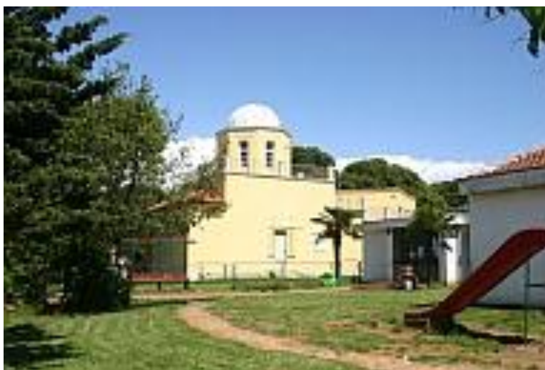
Slika 3. Izgled Zvezdarnice (nakon sanacije)
