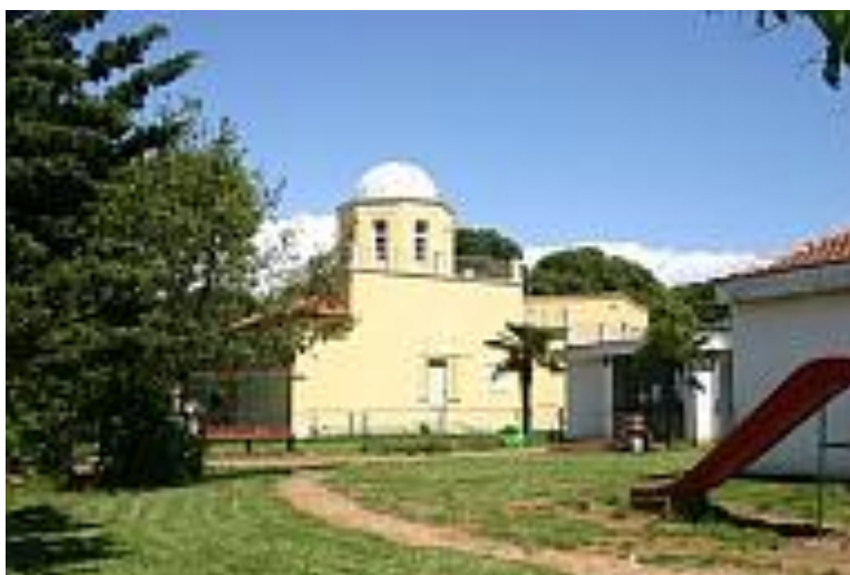
Slika 3. Izgled Zvezdarnice (nakon sanacije)
