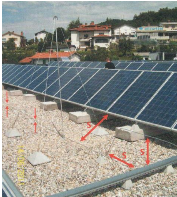
Slika 8 Primjer izoliranog sustava gromobranske zaštite
