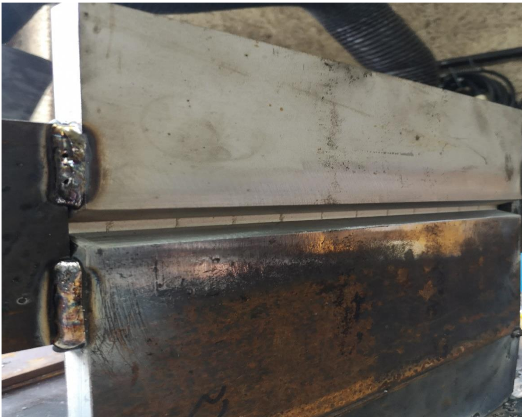
Slika 9 Pravilno postavljen spoj, pod pravim kutom
