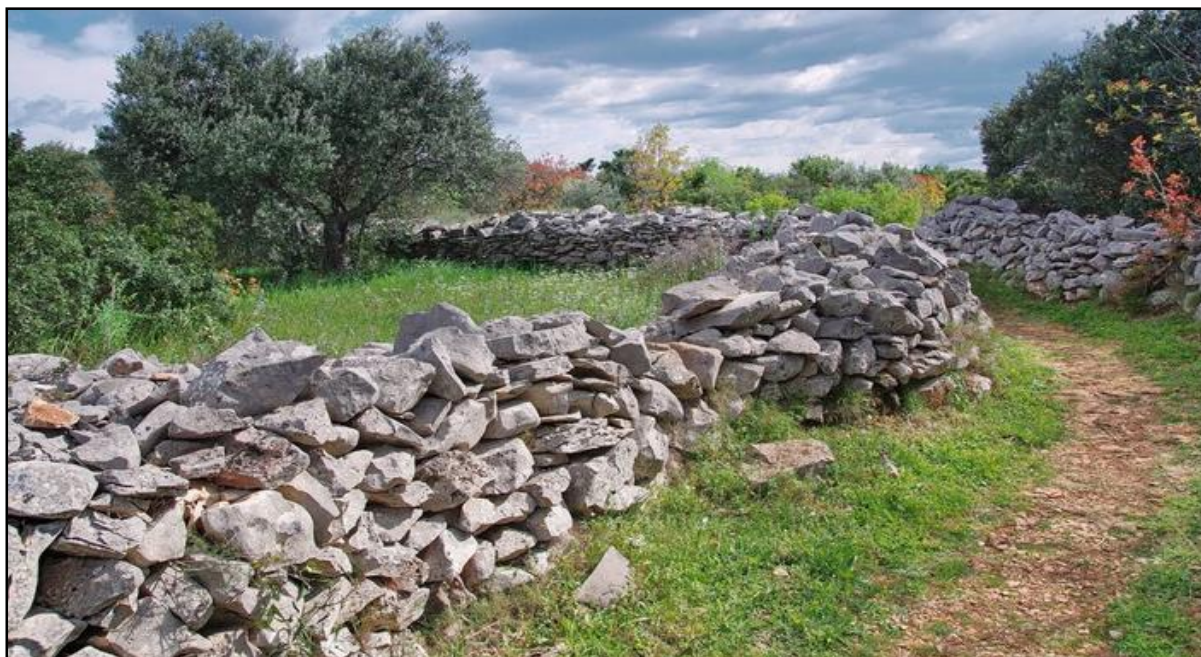
Slika 27. Umijeće suhozidne gradnje
