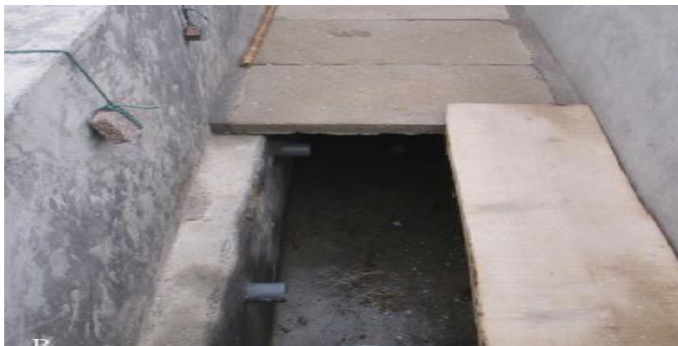
Slika 10. Odvod za ispuštanje vode iz bazena. (Izvor: Yucen Bai, 2015)
