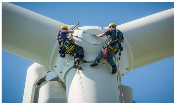
Slika 6. Prikaz održavanja vjetroelektrane
