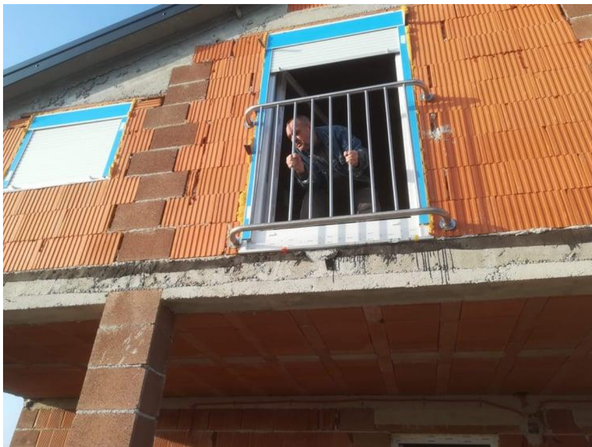
Slika 28. Montaža ograde
