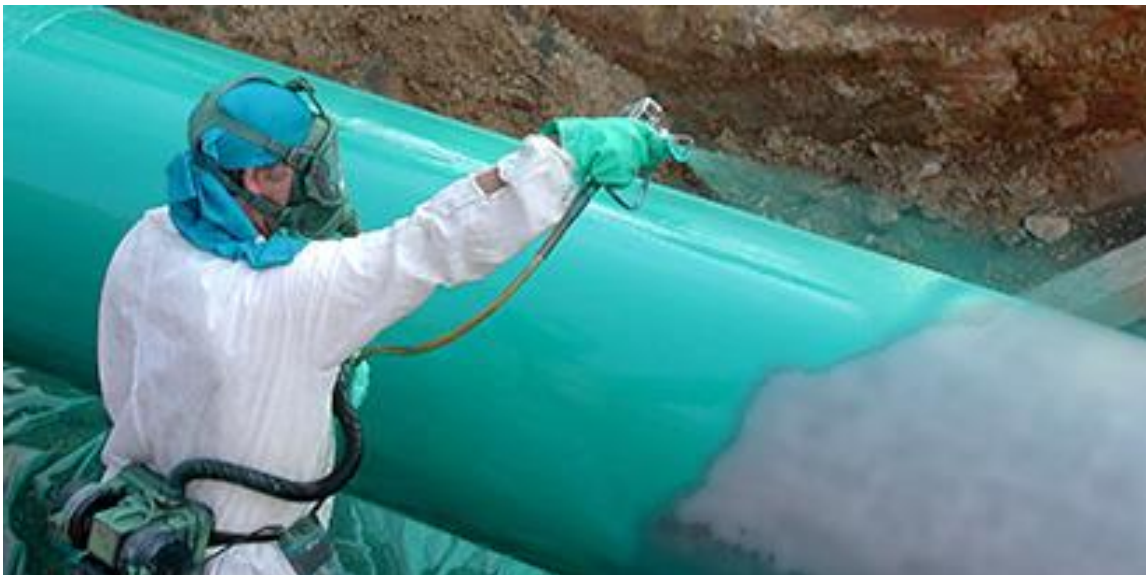
Slika 12 Primjer radnika koji zaštićuje cjevovod posebnim premazom. Izvor:
