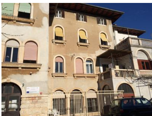
Slika 12: Zgrada Gerontološkog centra Vila Trapp Izvor: autor
