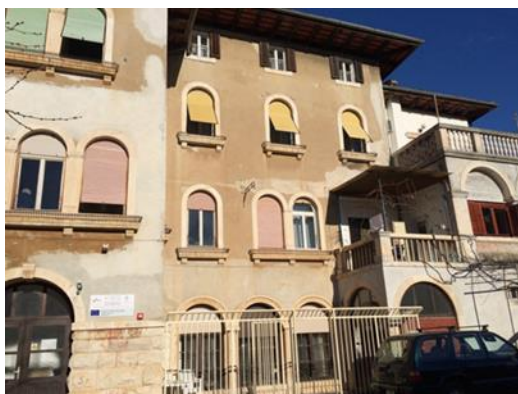
Slika 12: Zgrada Gerontološkog centra Vila Trapp Izvor: autor
