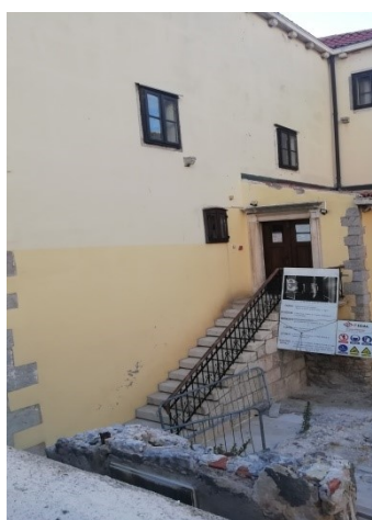
4d. Mjesto buduće dogradnje GMS
