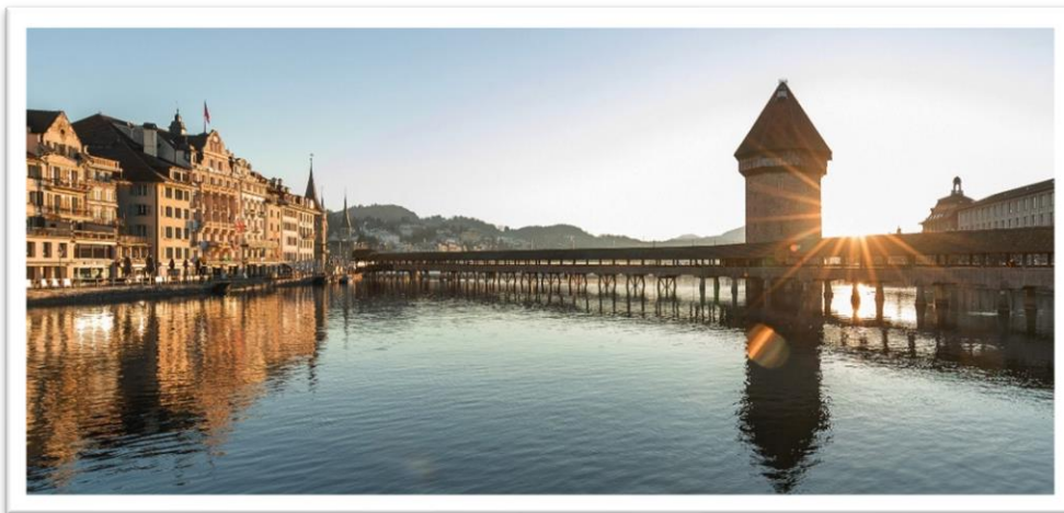
Slika 7. Drveni most Kapellbrücke
