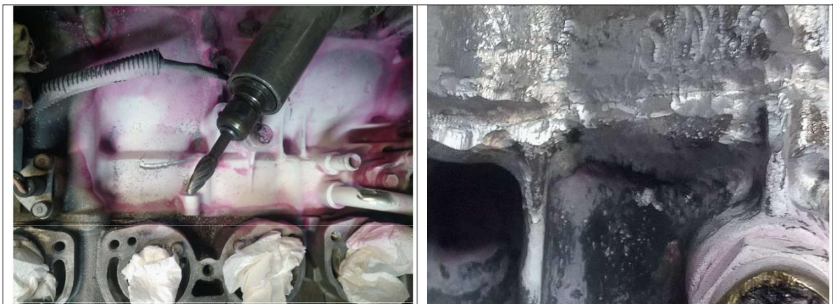
Slika 52. Nakon toga se pristupilo TIG postupku zavarivanja
