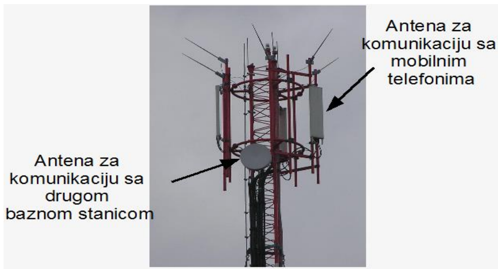
Slika 2.4. Fizički izgled bazne stanice
