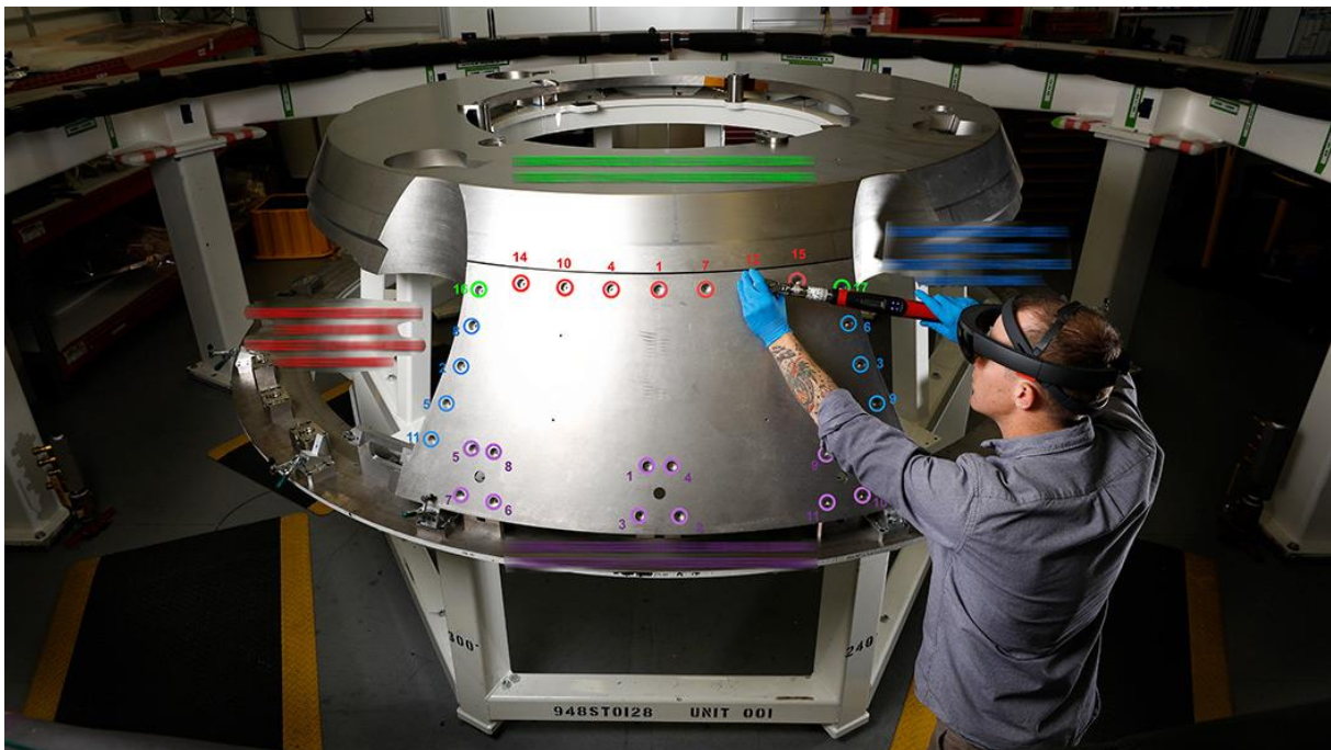
Slika 42. Primjena proširene stvarnosti prilikom montaže
