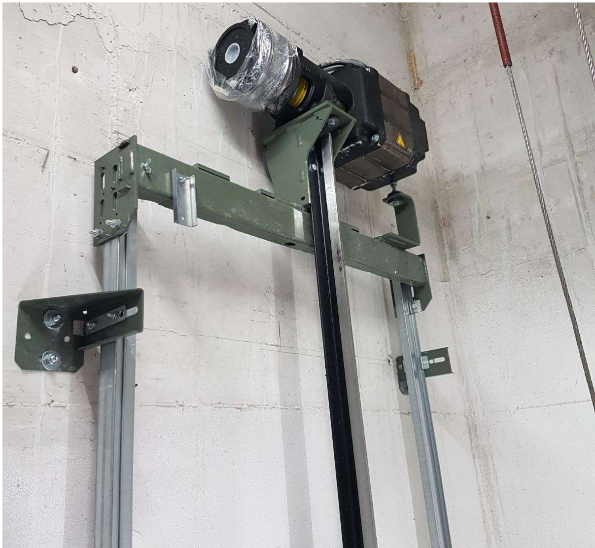
Slika 24. Pogonski motor na nosaču
