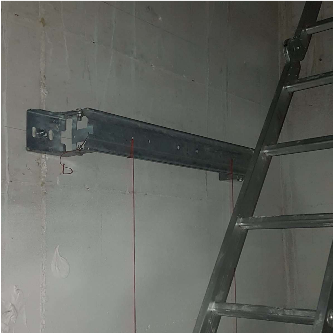
Slika 21. Omega konzola s dva viska
