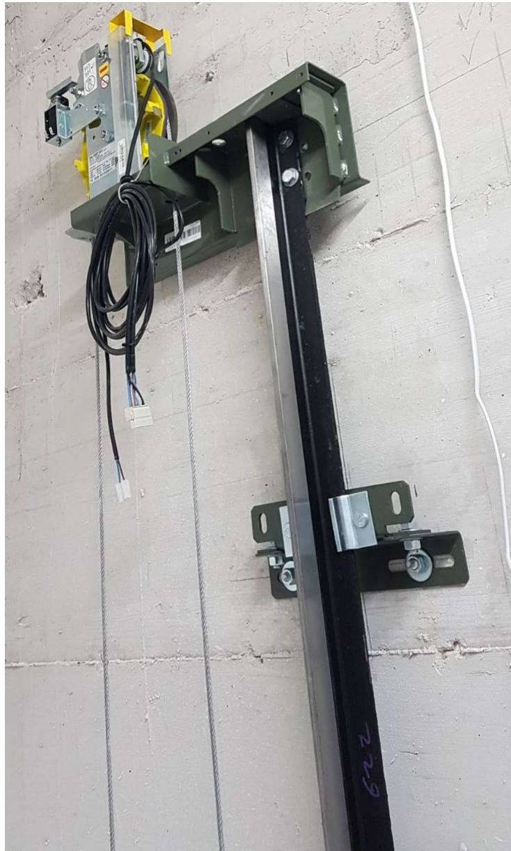
Slika 30. Kočioni sustav na nosaču samcu
