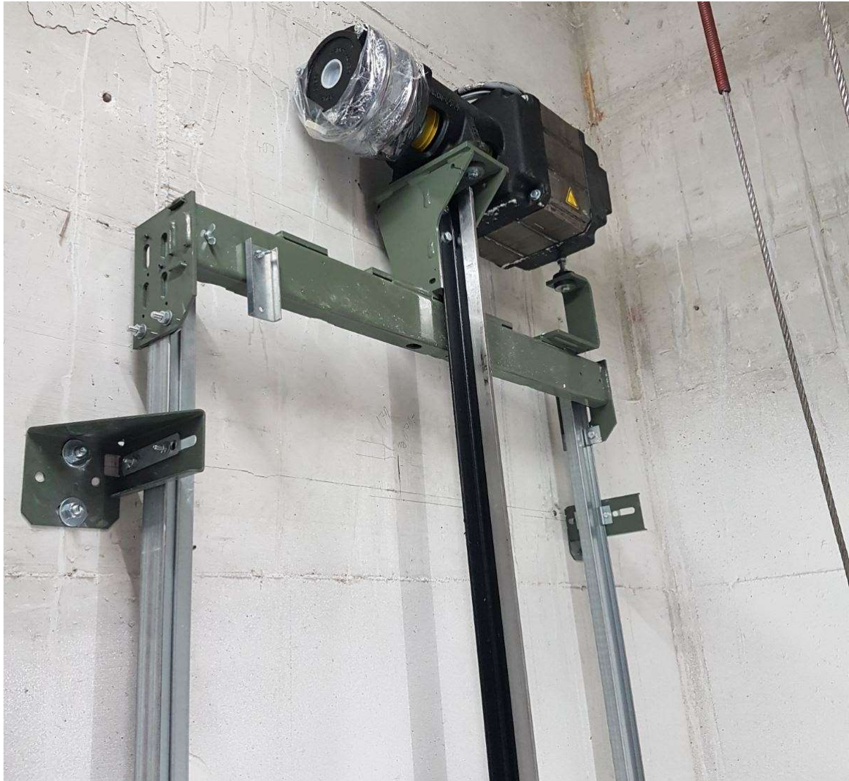
Slika 24. Pogonski motor na nosaču
