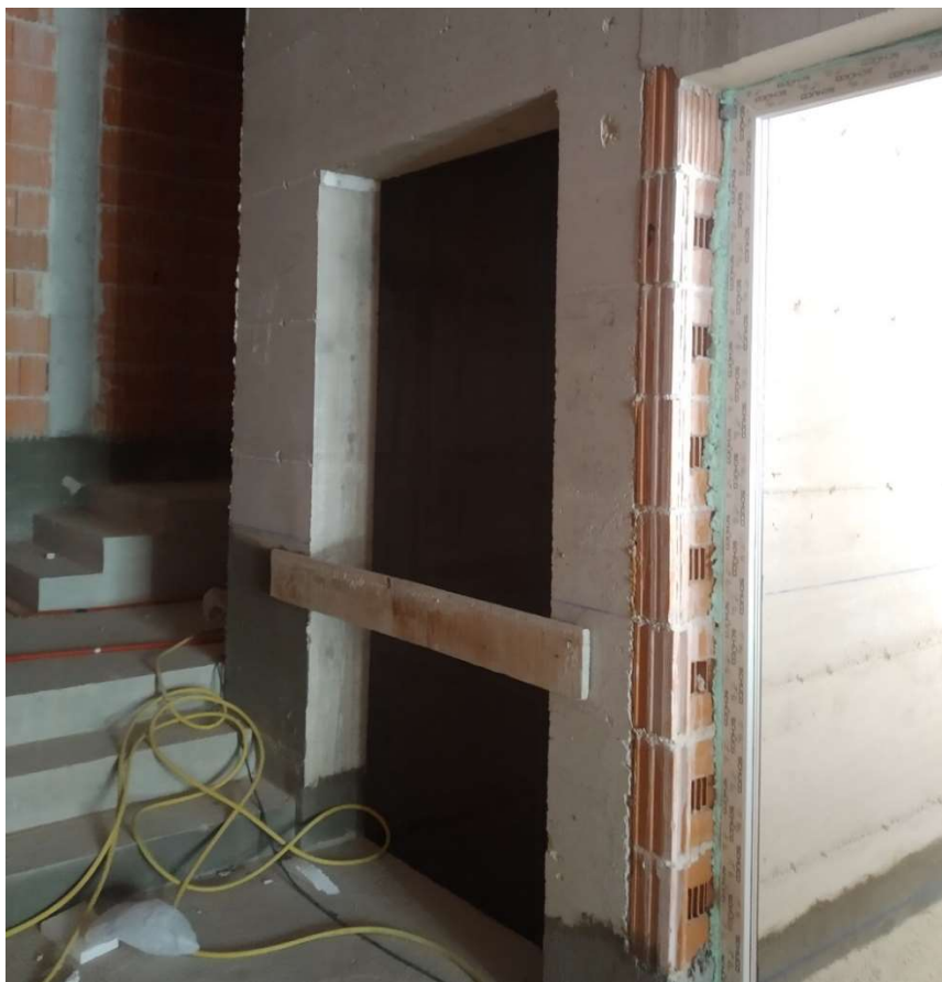
Slika 12. Okno dizala u prizemlju zgrade
