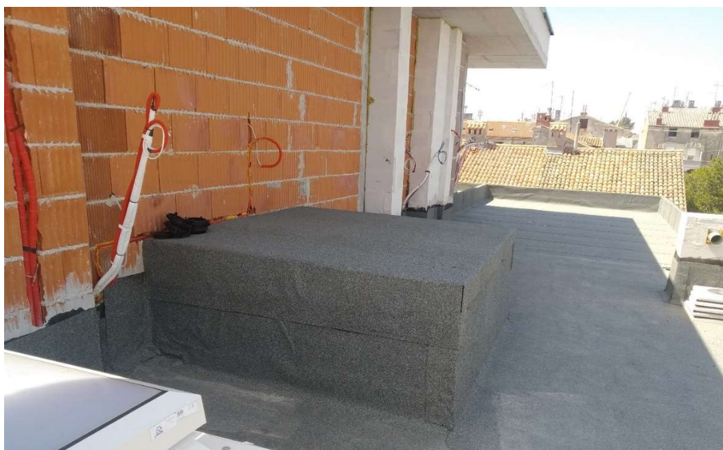
Slika 13. Nadvišenje okna lifta vidljivo na ravnom krovu građevine
