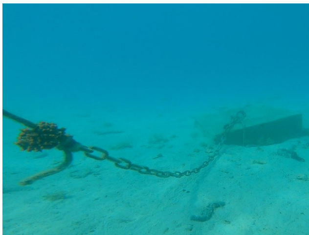
Slika 19. Betonski blok i lanac u području ski-lifta (izvor: osobna arhiva).
