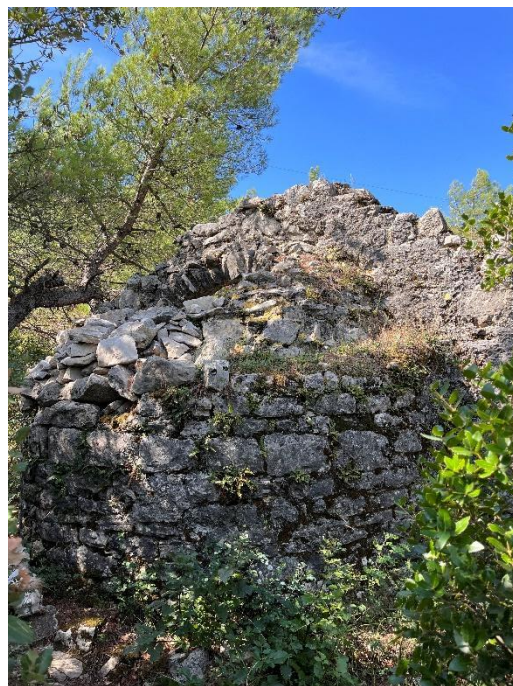
Slika 48. Vanjski izgled apside Snimila: Višnjčić, 2023.
