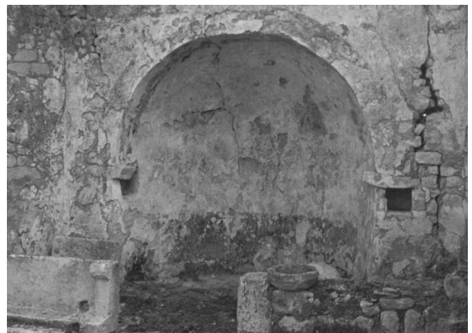
Slika 31. Unutrašnjost kapele i dio oltara
