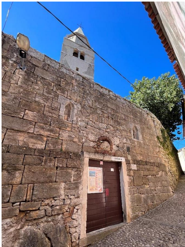
Slika 73. Pročelje crkve Sv. Justa i ulaz u zvonik
