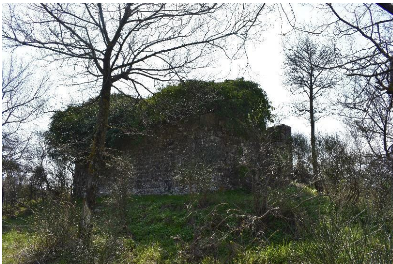
Slika 67. Vanjski izgled kapele
