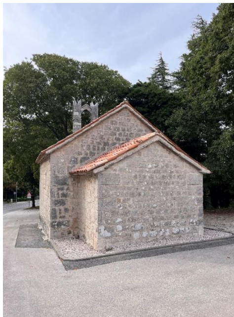
Slika 54. Vanjski izgled apside
