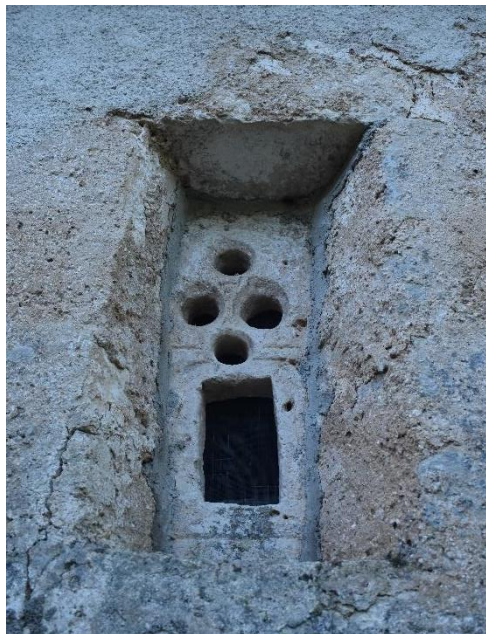
Slika 65. Prozor na sjevernom zidu
