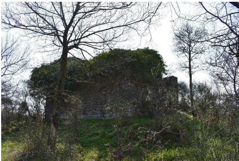
Slika 67. Vanjski izgled kapele
