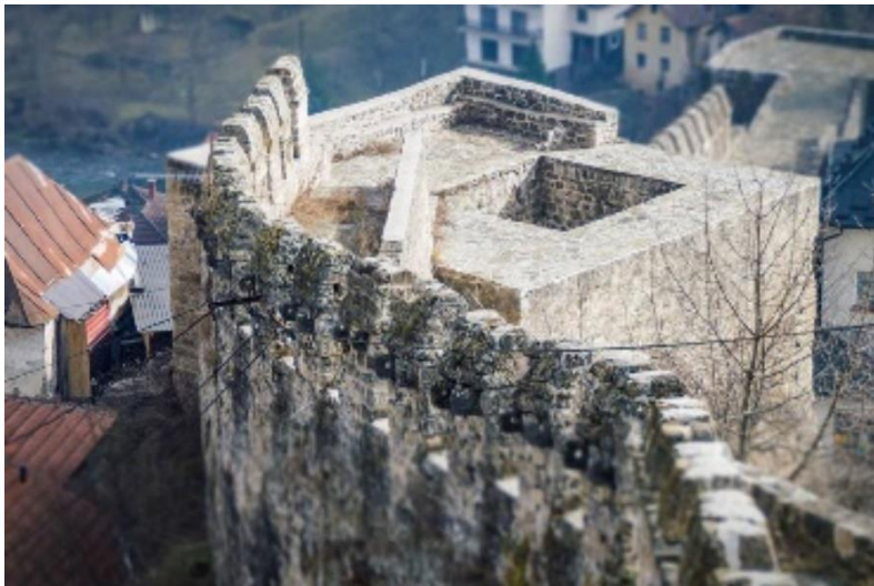
SI 61. Prikaz navedenih zidina s pogledom na dio Papaz kule te Šamića kule
