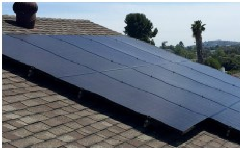
Slika 19. Fotonaponski sustav na tračnicama za kosi krov
