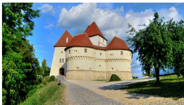
Slika 11. Veliki Tabor nakon obnove
