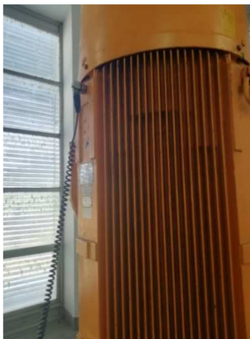
Slika 5.13 Mjerenje vibracija u smjeru V na položaju EM2 CA 7 crpne stanice Gradole
