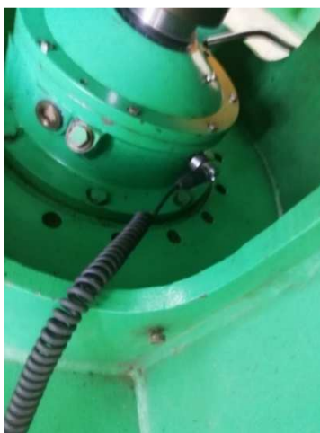
Slika 5.16 Mjerenje vibracija u smjeru H na položaju A CA 7 crpne stanice Gradole
