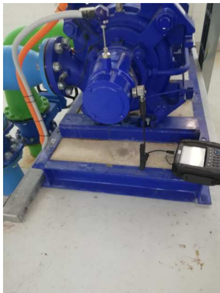
Slika 5.9 Mjerenje vibracija u smjeru H na položaju B CA 4 crpne stanice Sv. Stjepan
