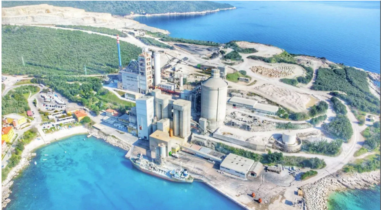
Slika 4.1. Tvornica Holcim u Koromačnom [9]
