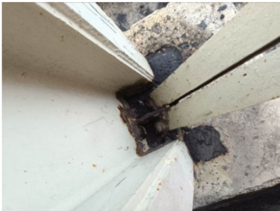
Slika 4.1.1.3. Vizualna kontrola konstrukcija [9]
