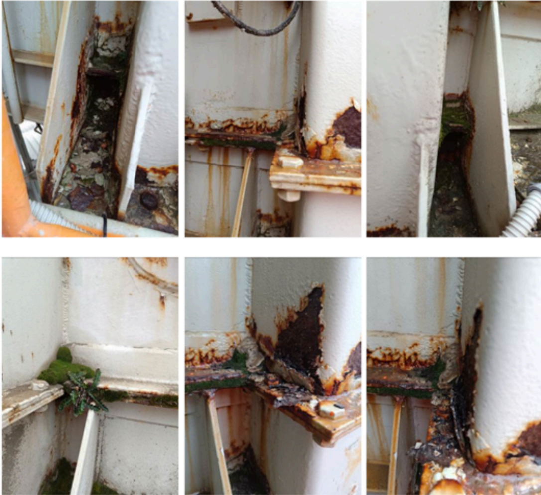
Slika 4.1.1.1. Vizualna kontrola konstrukcija [9]
