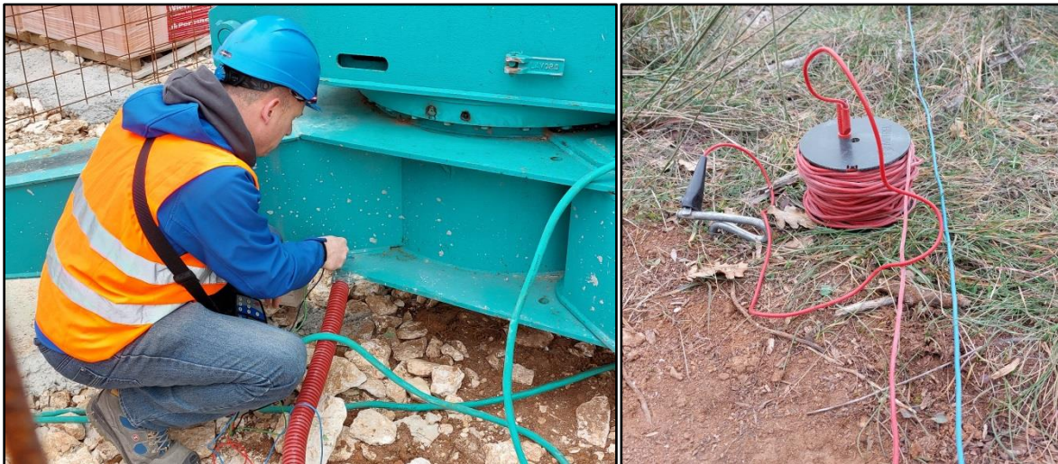
Slika 9: Ispitivanje otpora uzemljenja instrumentom Metrel Eurotest XA
