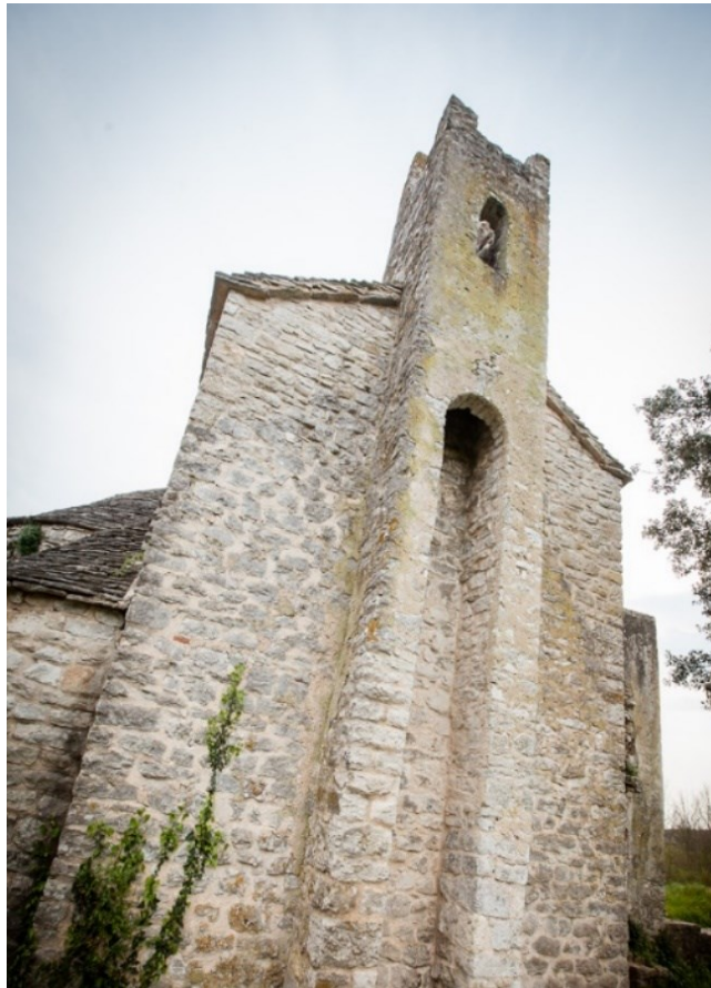
Slika 11. Crkva sv. Tome - pogled na pročelje
