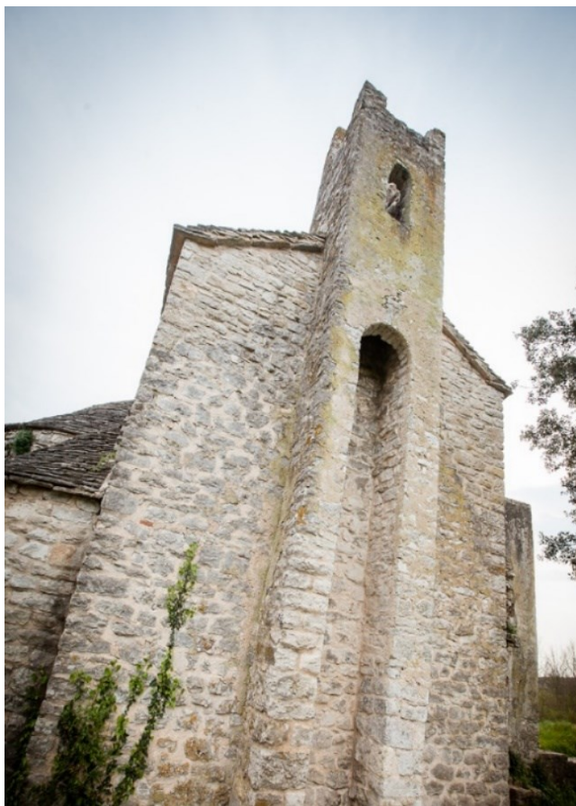
Slika 11. Crkva sv. Tome - pogled na pročelje
