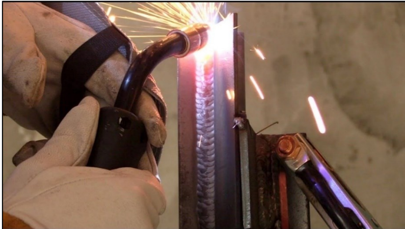
Slika 8. MIG Zavarivanje
