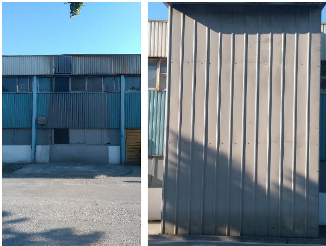
Slika 18. prije i nakon postavljanja ciklona
