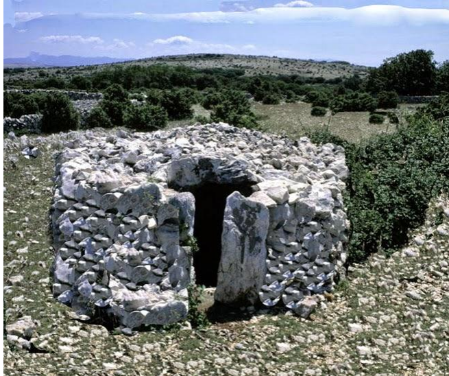
Slika 36. Zidano pokriveno pojilo za ovce Izvor: www.dragodid.hr
