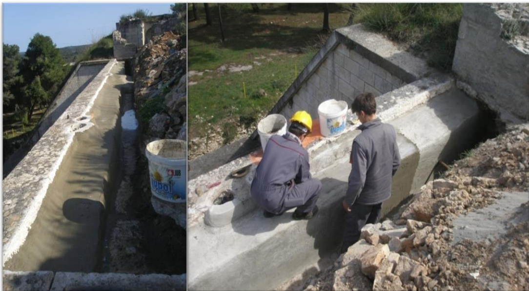
Slika 5. Rekonstrukcija krovišta Fort Verudele (Interna dokumentacija Aquariuma Pula d.o.o.)
