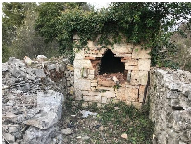
Slika 21. Obnova krušne peći, Rakalj
