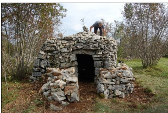
Slika 7. Primjer suhozidne gradnje u Sloveniji
