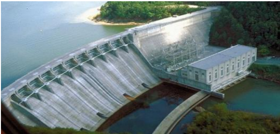
Slika 4. Hidroelektrana u Hrvatskoj ( Izvor : http://www.lolhr.com/blogovi/energetika/39-hidroelektrane-u-hrvatskoj.html , 2016.)
