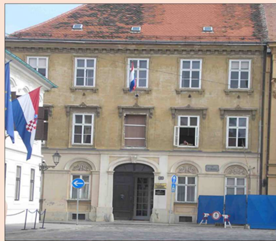
Slika 2. Zgrada na Trgu sv. Marka nekadašnjeg MVP-a
