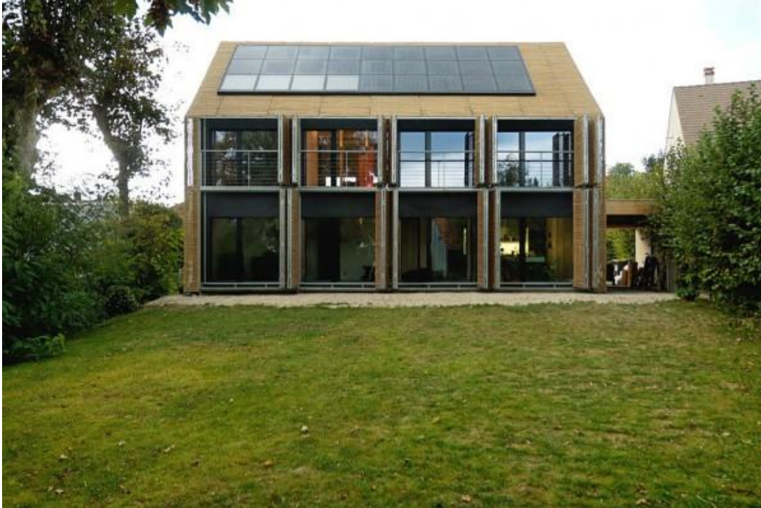
Slika 31: Pasivna solarna kuća prema principu direktnog sunčevog zahvata
