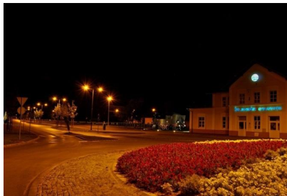
Slika 8. Zgrada željezničkog kolodvora
