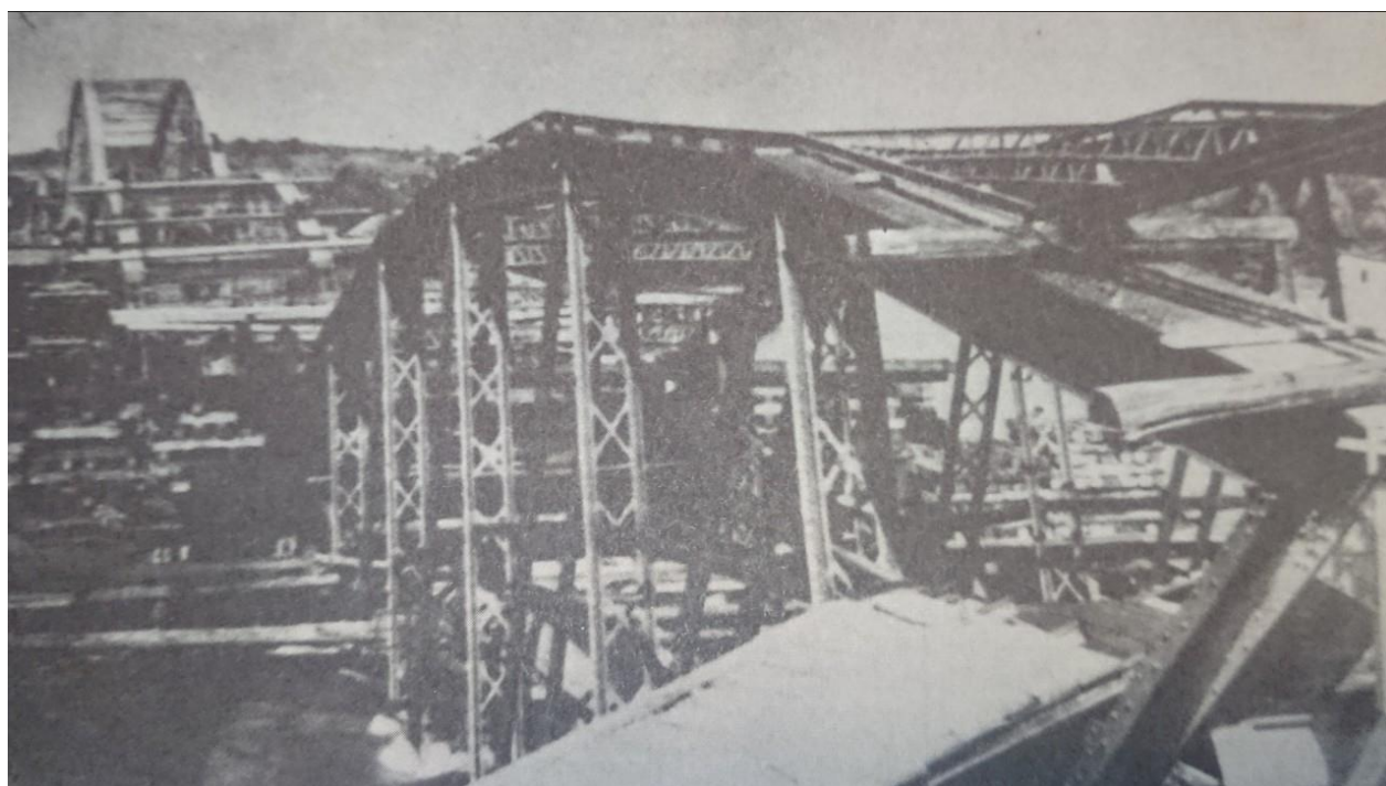
Slika br. 12. – Srušeni most na Dravi kod Botova, u noći 6. na 7. travnja 1941.
