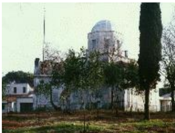
Slika 2. Izgled Zvjezdarnice (prije sanacije)
