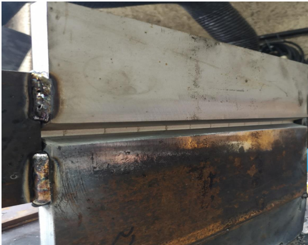
Slika 9 Pravilno postavljen spoj, pod pravim kutem
