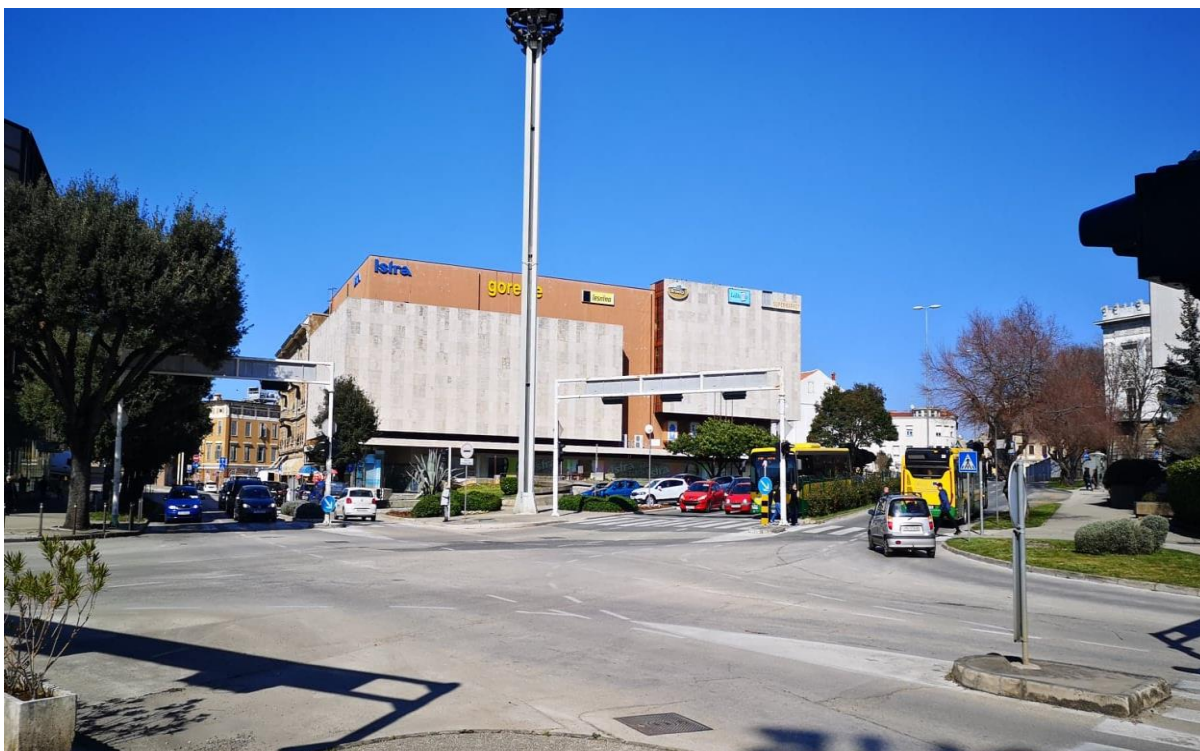
Slika 11. Robna kuća Pula
