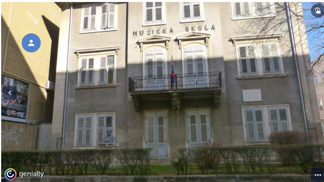
Slika 8. Bivša zgrada Glazbene škole „Ivana Matetića Ronjgova“ u Puli
