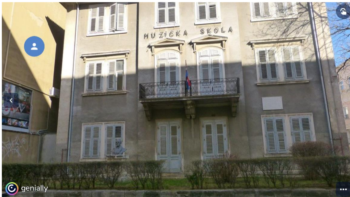
Slika 8. Bivša zgrada Glazbene škole „Ivana Matetića Ronjgova“ u Puli
